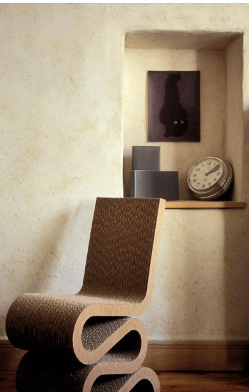
Les matériaux, révélés par la lumière, modifient la perception des volumes et qualifient les ambiances. Ci-dessus, un enduit épais chaux-chanvre, finement taloché, habille les parois de moellons et joue son rôle de correcteur thermique.
