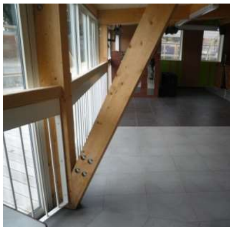
☹ Un ajout en mobilier ou claustra à l'aplomb des 2.20 m sécurisera le cheminement
