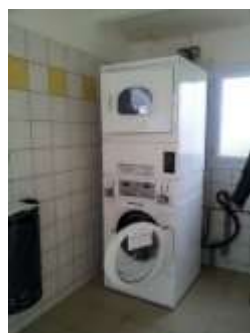
😊 Le lave-linge (en bas) ainsi que son monnayeur sont accessibles. En revanche, le sèche-linge (en haut) ne l'est pas
