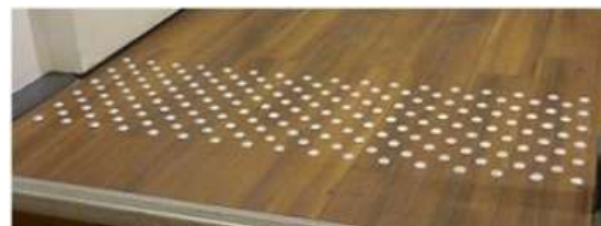
😊 Exemple d'éveil à la vigilance sous forme de « clous podotactiles » utilisables sur tous supports et de couleurs diversifiées afin de prendre en compte la nature du sol
