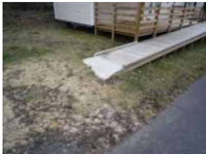
😞 Une pente d'accès qui communique avec un terrain non conforme (herbe)
