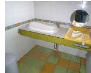
☺ Espace pour le passage des jambes conforme sous la table à langer
