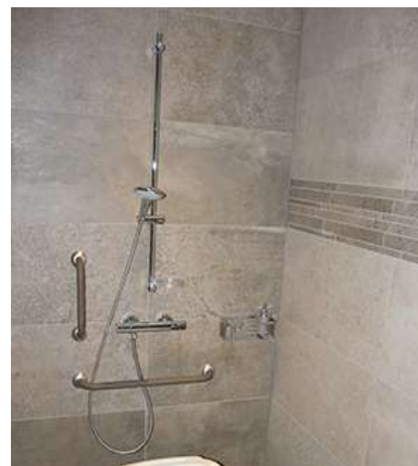
😊 Présence d'une barre de transfert horizontale et une verticale, conformément à la réglementation
