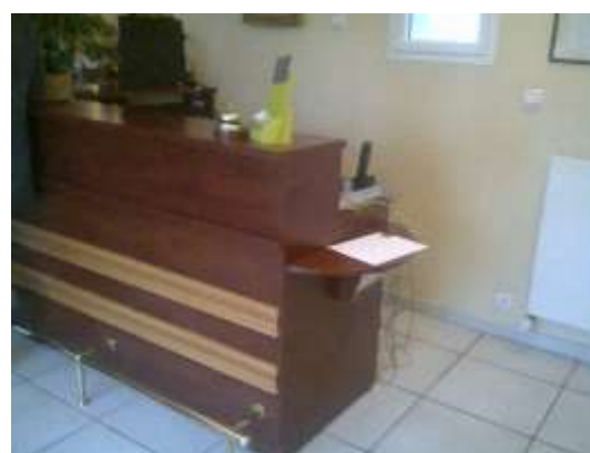
☹️ Tablette sur le côté trop petite aux dimensions non conformes. Elle n'est pas utilisable par une personne en fauteuil roulant.
