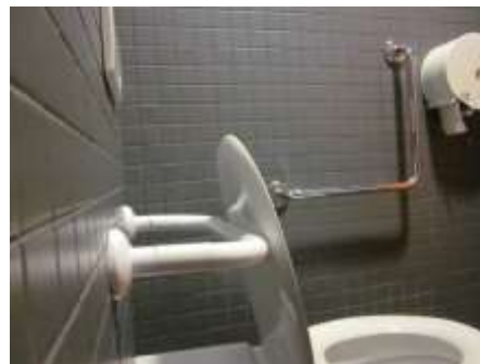
😊 Un dossier a été fixé au mur pour permettre à la personne handicapée moteur de s'appuyer et de rester ainsi assise confortablement
