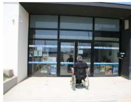
😊 Porte bien repérable. Eléments visuels contrastés posés sur les portes vitrées à 2 hauteurs
