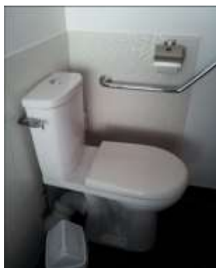
😊 Aménagement du WC conforme (accès aux différents équipements)
