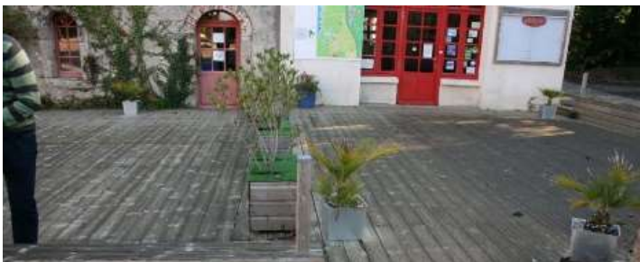
😊 L'accès à ce bâtiment, proposant plusieurs marches, a été facilité par la réalisation d'une terrasse supprimant tous les ressauts au niveau des portes
