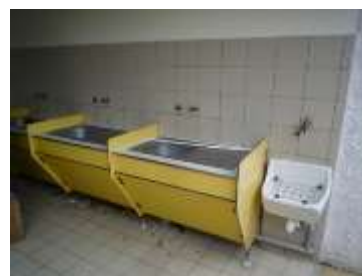
☹ La découpe du panneau frontal peut résoudre la non-conformité mais il faudra aussi mesurer la hauteur et la profondeur réelles
