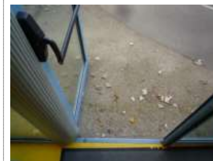
☹ La barre anti-panique à levier rend le passage utile non conforme. Une barre à pression (moins épaisse donc) est préconisée
