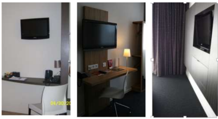
☺ Un mobilier sous la télévision permet de sécuriser le cheminement près de la télévision qui déborde de plus de 15 cm du mur et qui présente un obstacle à hauteur du visage. Photo 3 : télévision intégrée dans un mobilier qui ne présente pas d'obstacle sur le cheminement
