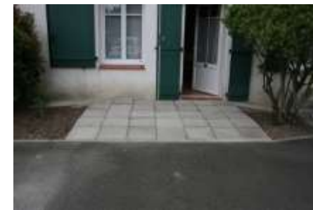
😊 L'accès à cette chambre d'hôtel a été aménagé avec un plan incliné et un palier de repos réglementaires, permettant une bonne circulation
