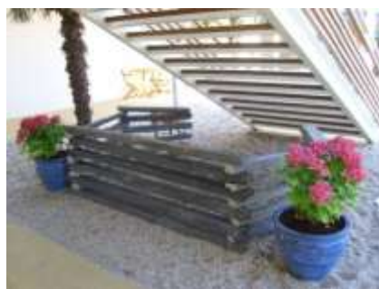
☺ Exemple pour neutraliser un escalier
