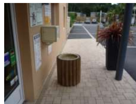
☹ Déplacer la poubelle sous la boîte aux lettres neutralisera l'obstacle en saillie
