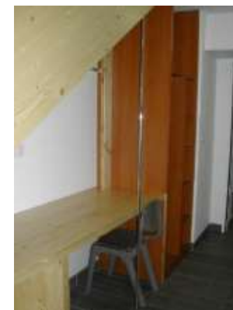
☺ Le bureau, empêchant de s'engager sous l'escalier, permet de neutraliser l'obstacle à hauteur de tête provoqué par l'escalier
