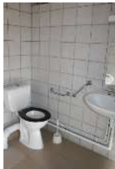
😊 Les deux barres de transfert du WC peuvent être en deux morceaux s'il s'agit de compléter l'équipement par l'une ou l'autre des barres
