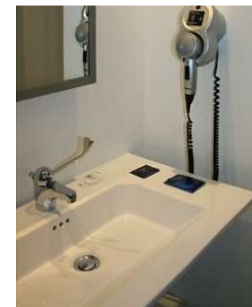
😊 La robinetterie avec poignée allongée est facilement utilisable. Le sèche-cheveux est également préhensible. A noter : le miroir est un peu trop haut
