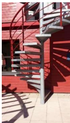
☹ Un tel escalier doit impérativement être matérialisé en dessous (jusqu'à 2.20m) afin qu'une personne mal voyante ou aveugle ne s'y cogne pas
