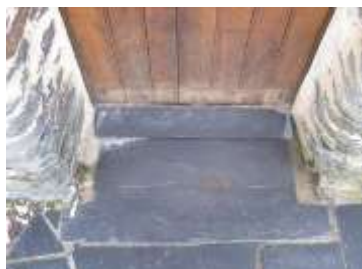
😊 La traverse a été supprimée et une plaque d'ardoise franchit le ressaut sans dénaturer l'aspect patrimonial de la maison.
