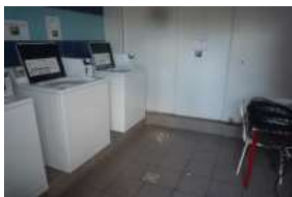
☹ Ici ouverture supérieure à 1.30 m et monnayeurs inatteignables
