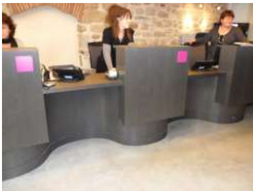
😊 Exemple de comptoir d'accueil adapté. La réglementation accessibilité oblige au minimum un poste d'accueil adapté. Sur cette photo, le prestataire est allé plus loin dans sa démarche d'accueil en proposant des parties surbaissées pour chaque poste d'accueil
