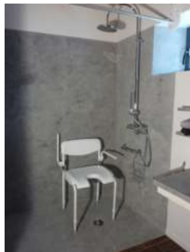
😊 Exemple de douche accessible, avec siège amovible permettant de choisir le sens de transfert.
